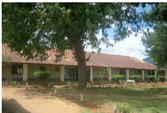
Dit gebouw wordt nu gerenoveerd
